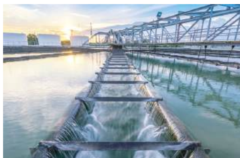
Fig. 3. Stație de tratare a apei potabile
