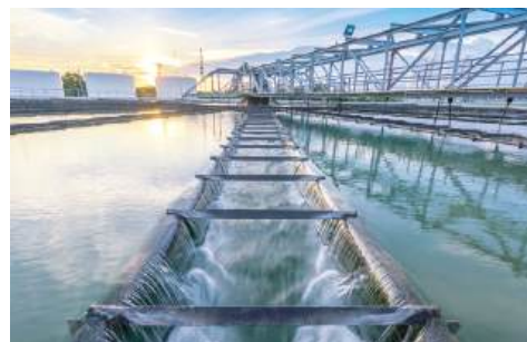
Fig. 5. Stație de tratare a apei potabile
