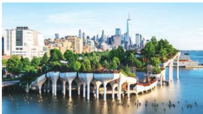
Fig. 14. Little Island, parc creat pe o insulă artificială, sprijinită pe 132 de piloni de beton în formă de lea, ridicați deasupra apei, fluviul Hudson, New York
