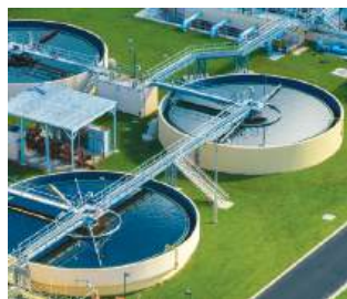
Figura 2. Stație de epurare a apei
