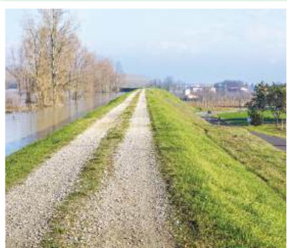
Dig pentru prevenirea inundațiilor
